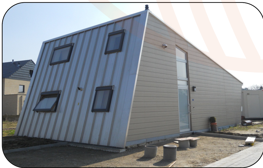
ZEMST, Elewijt, Solariumlaan
